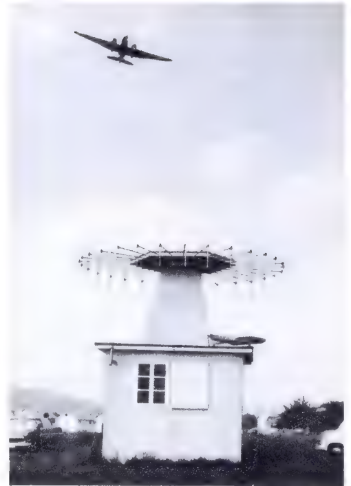
Lorenz-Großbasis-Dopplerpeiler auf einem Flugplatz
